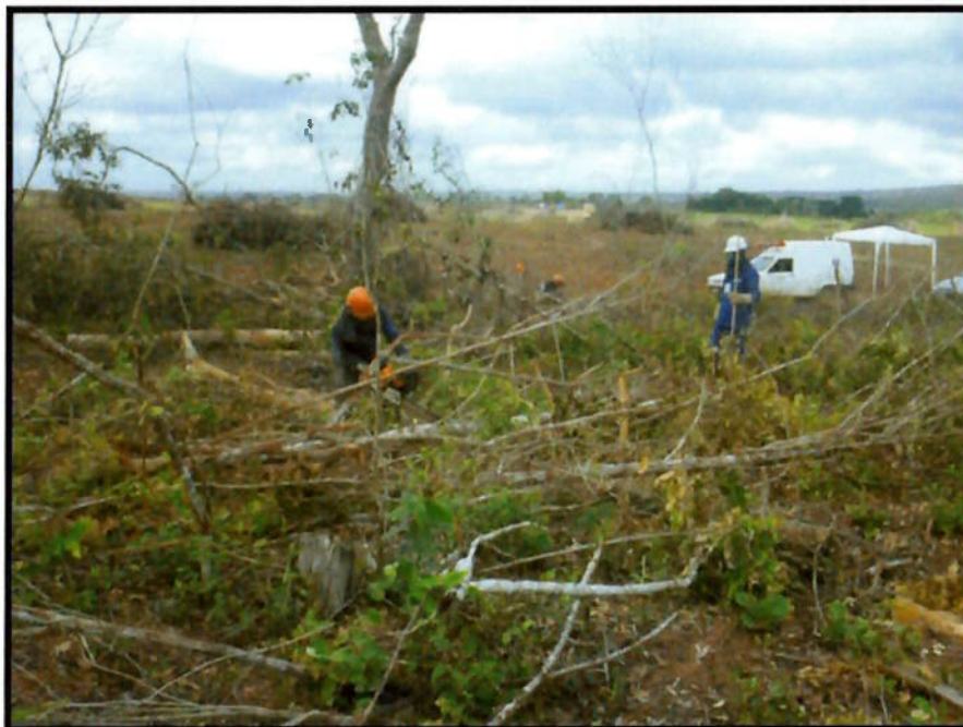
Figura 6 – Supressão de vegetação semimecanizada (Silva, 2008).
