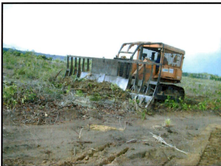
Figura 3 – Supressão de vegetação para construção de hidrelétrica (Silva, 2008).
