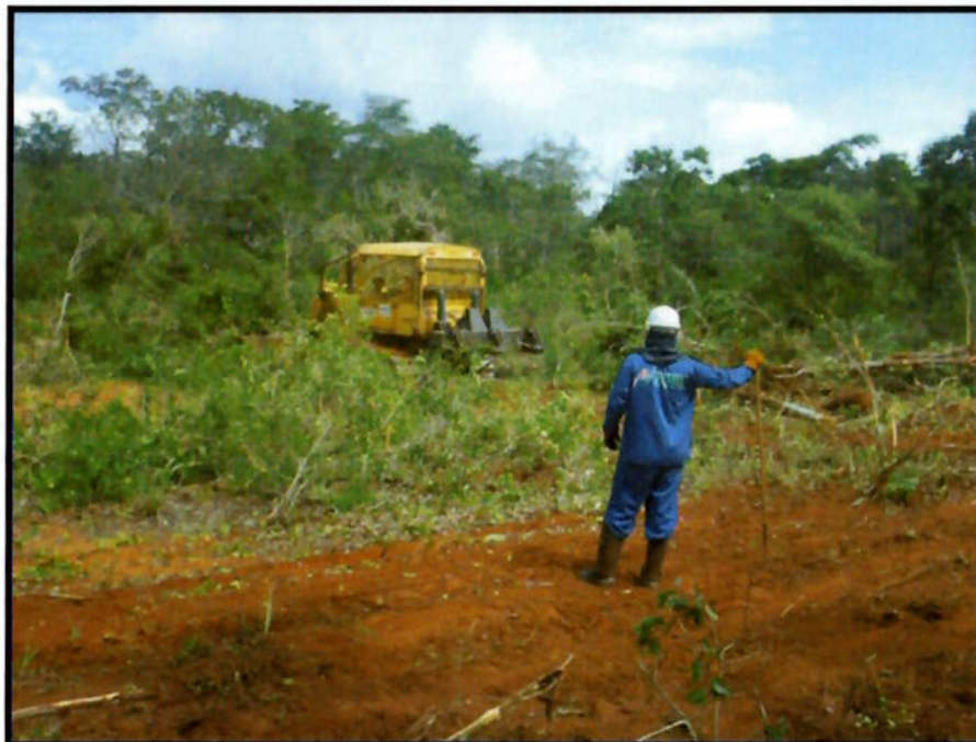
Figura 7 – Supressão de vegetação mecanizada (Silva, 2008).
